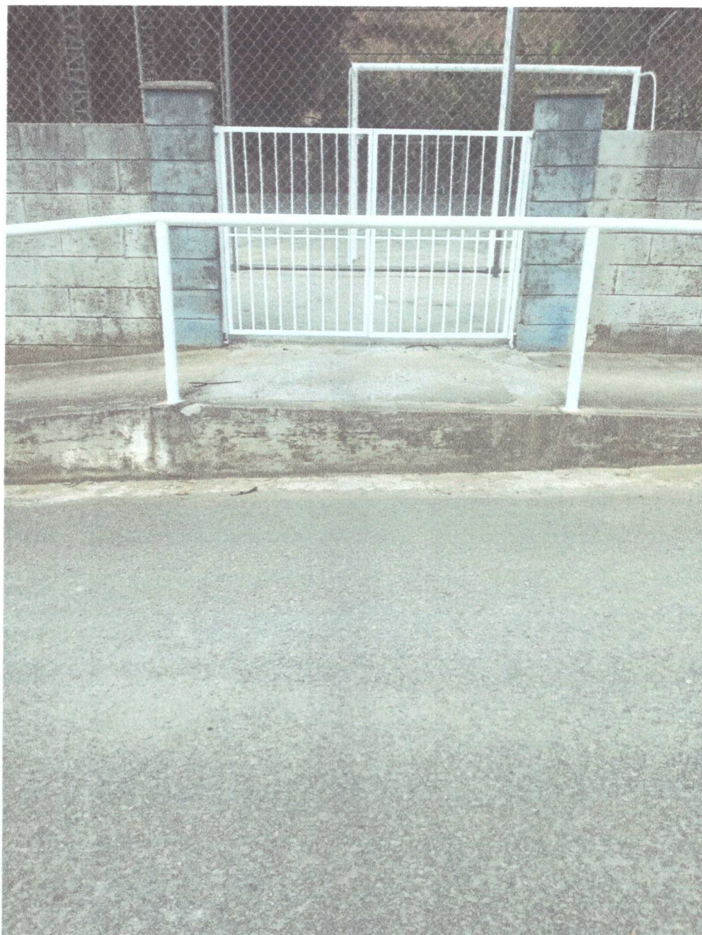
COLOCAÇÃO DE PORTÃO DE FERRO
