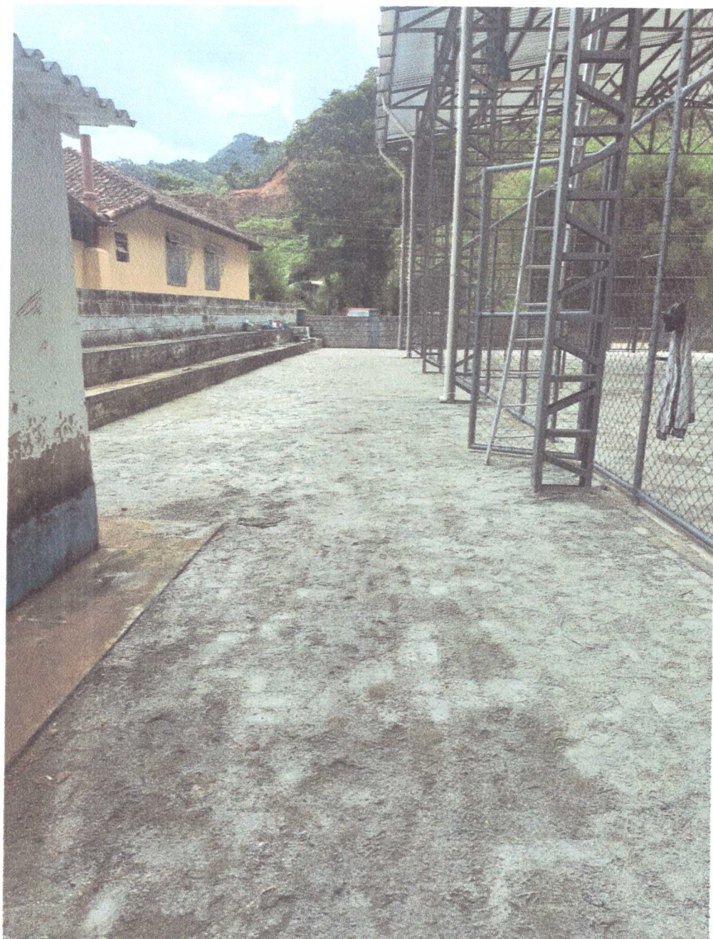
PAVIMENTAÇÃO EXTERNA COM INTERTRAVADO
