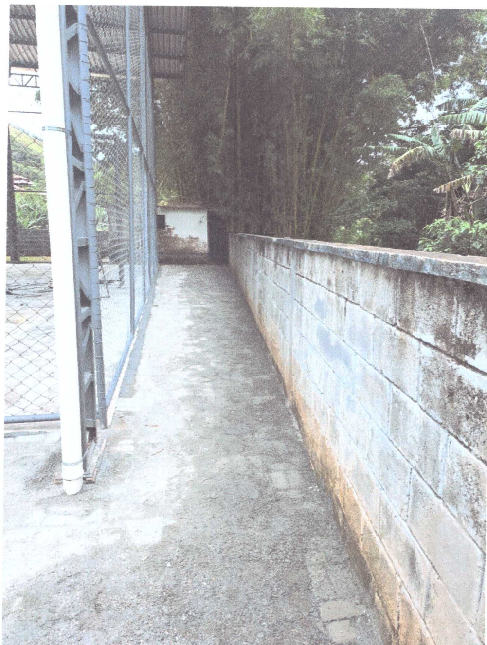
PAVIMENTAÇÃO EXTERNA COM INTERTRAVADO
