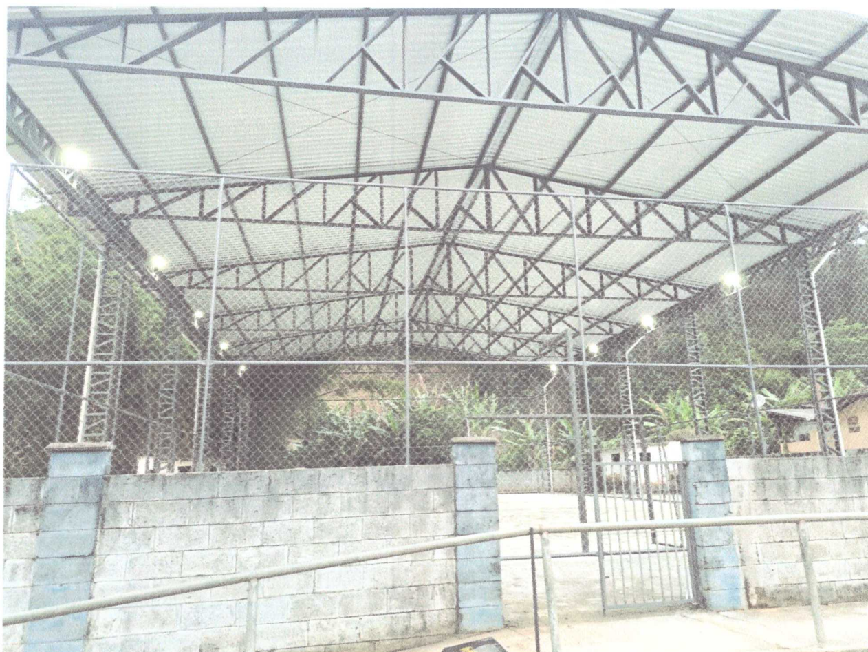
COLOCAÇÃO DE ALAMBRADO E REFLETORES
