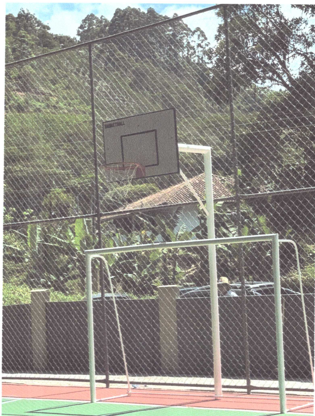
COLOCAÇÃO DE ALAMBRADO, PINTURA DO TUBO E DO PISO DA QUADRA E COLOCAÇÃO DE TABELA DE BASQUETE E TRAVES DE FUTSAL
