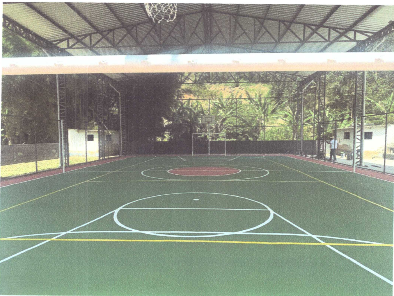
PINTURA DE PISO DA QUADRA E PINTURA DO MURO
