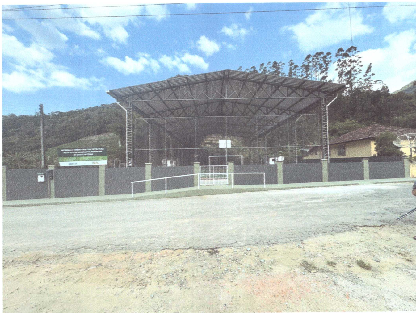
PINTURA DO MURO EXTERNO
